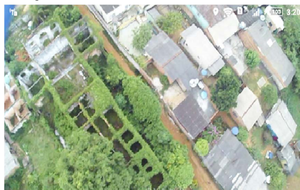
Figura 2. Vista aérea do Terreiro de Oxum Aladê
