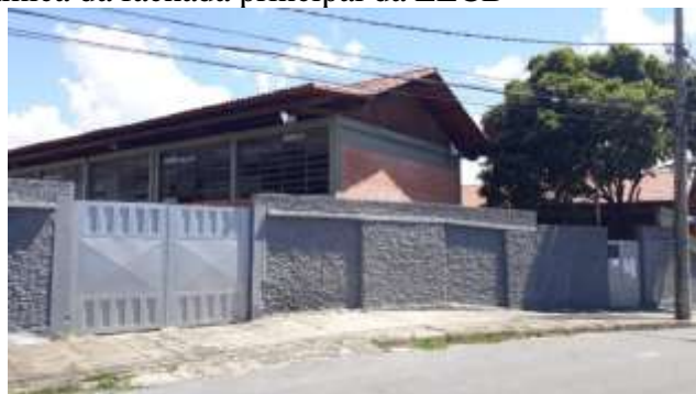
Fig.2 – Panorâmica da fachada principal da EECB
