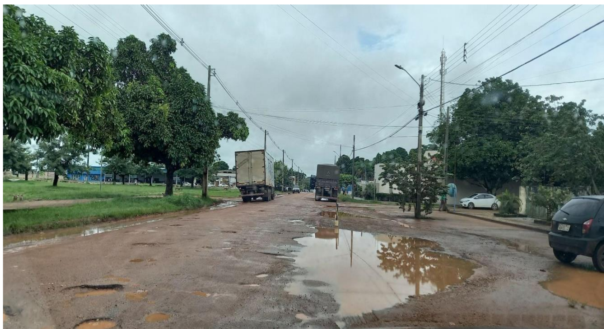
Foto da avenida onde é realizada grande parte das vistorias físicas pela SEFIN em Guajará-Mirim.
